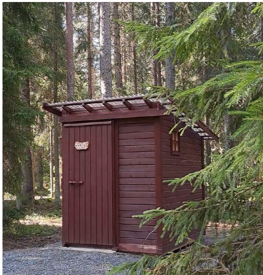
Vuonna 2022 rakennettu esteetön WC Lemmenlaakson luonnonsuojelualueen pohjoispäässä.
